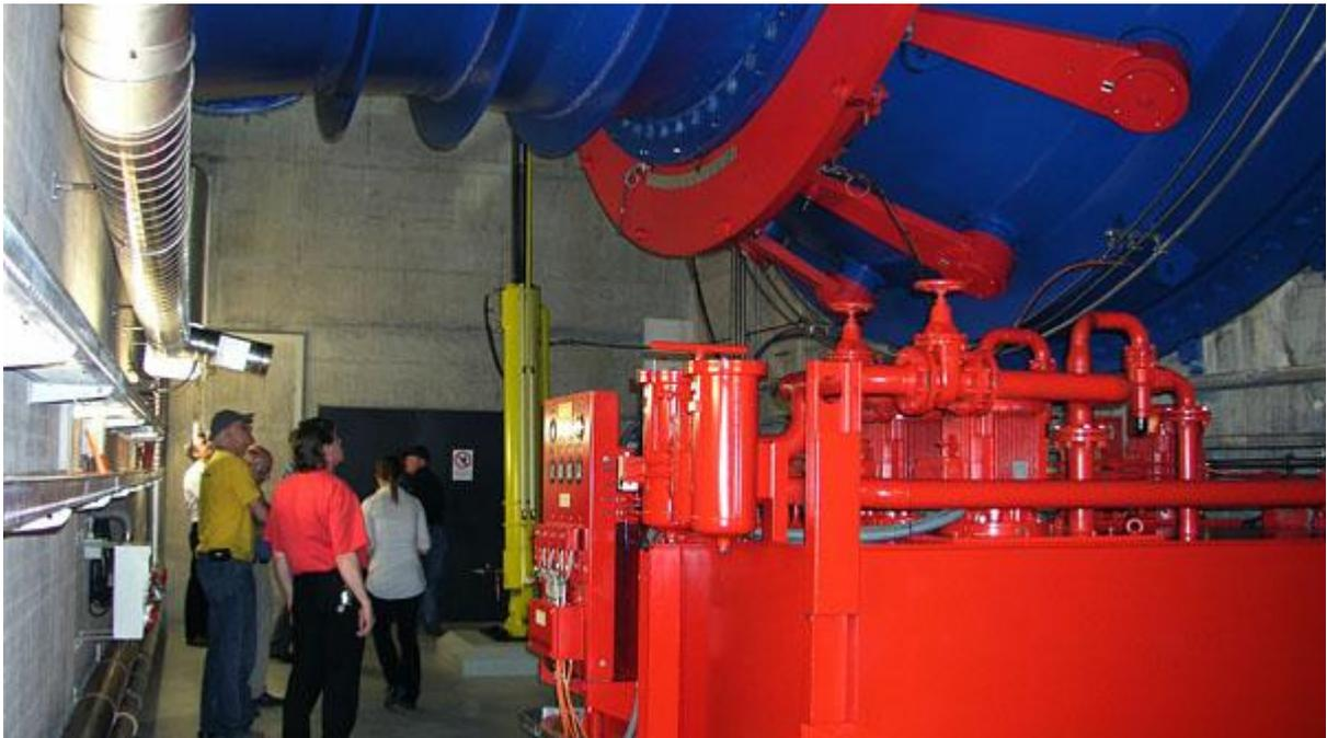
Der Beton vibriert, da unten bei den beiden über 5 Meter grossen Kaplan turbinen dröhnt es laut. Oben fliesst der halbe Fluss durch die Röhre. Das Wasser überträgt Bewegung an die Stromgeneratoren, zweimal 20 Megawatt, ergibt pro Jahr 115 Mio kWh.
