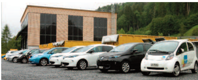
Einige der Elektrofahrzeuge beim Laden an der Solarhalle
