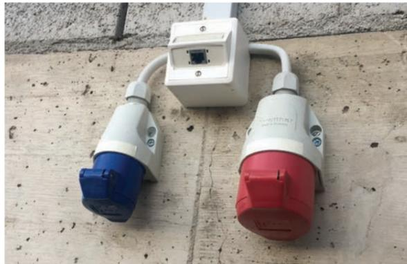
**Abbildung 8:** optimale Vorrichtung für eine spätere Ladestation: CEE-Steckdose.
